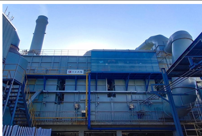
80000Nm 3 /h RTO 处理废气
