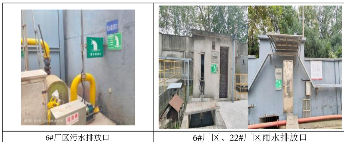
企业在 6# 厂区废水排放口及废气 RTO 焚烧装置排放口安装在线监控设施，并与环保部门联网，监测因子包括：流量、pH、COD<sub>Cr</sub>、氨氮、总氮及非甲烷总烃；22# 厂区固液焚烧炉废气排放口安装在线监控设施，并与环保部门联网，监测因子：流量、颗粒物、CO、NO<sub>x</sub>、SO<sub>2</sub>、HCl；在线监控设施相关备案文件详见附件 5。
